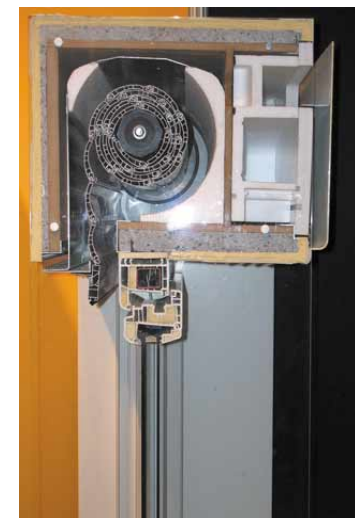
esempio di isolamento del cassonetto
