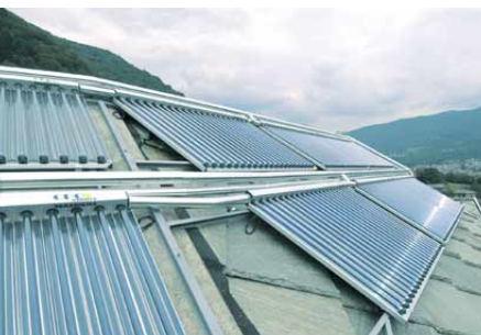
impianto solare sottovuoto
