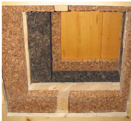
isolamento con pannelli di sughero
