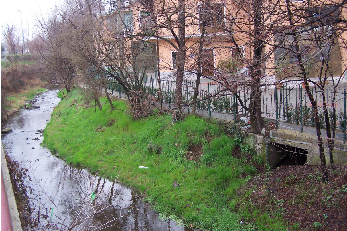
Sponda sinistra rio Sangonetto lungo Via Segheria a Piosasco
