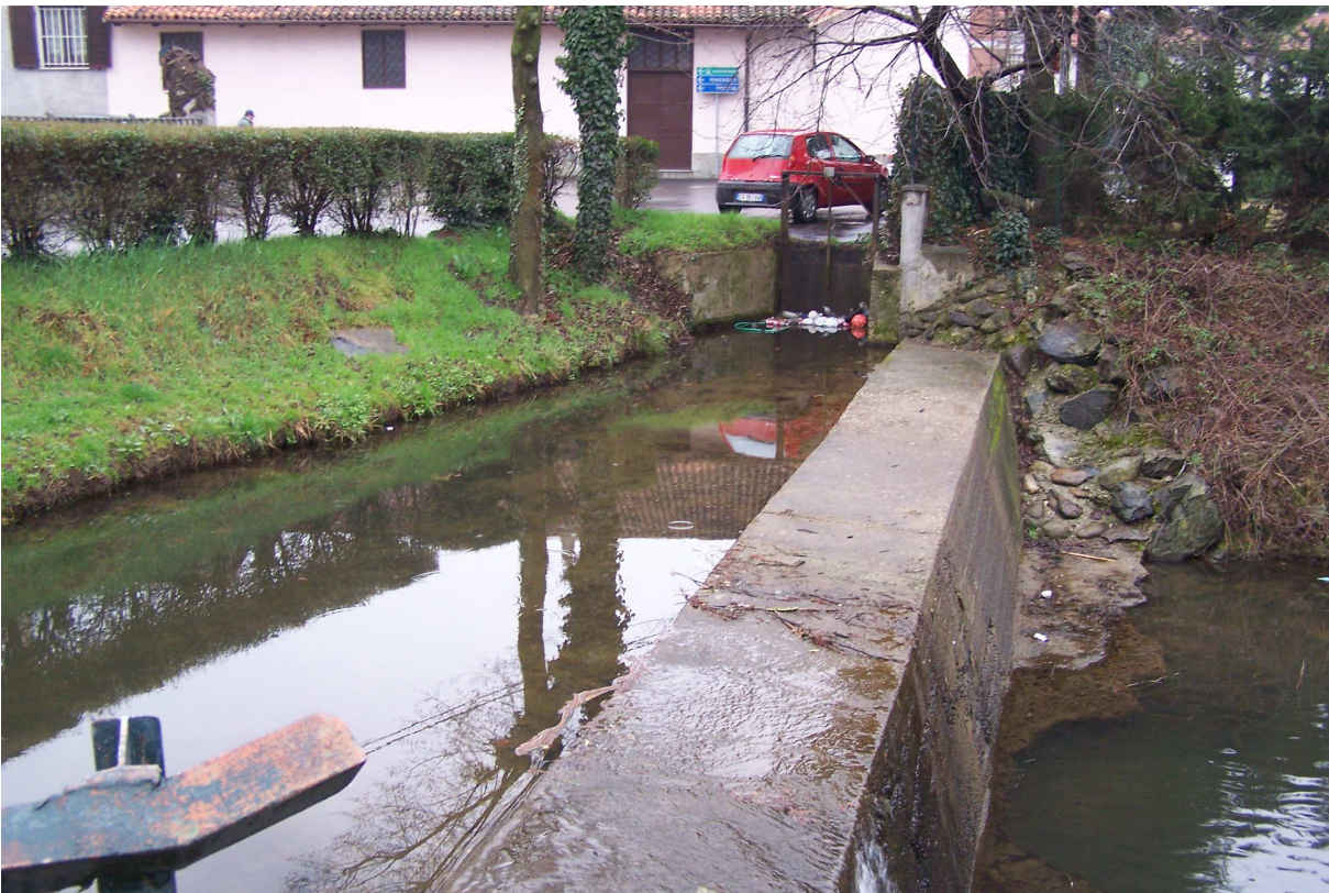
Opere di derivazione presso il ponte Borgiattino sul rio Sangonetto a Piosasco
