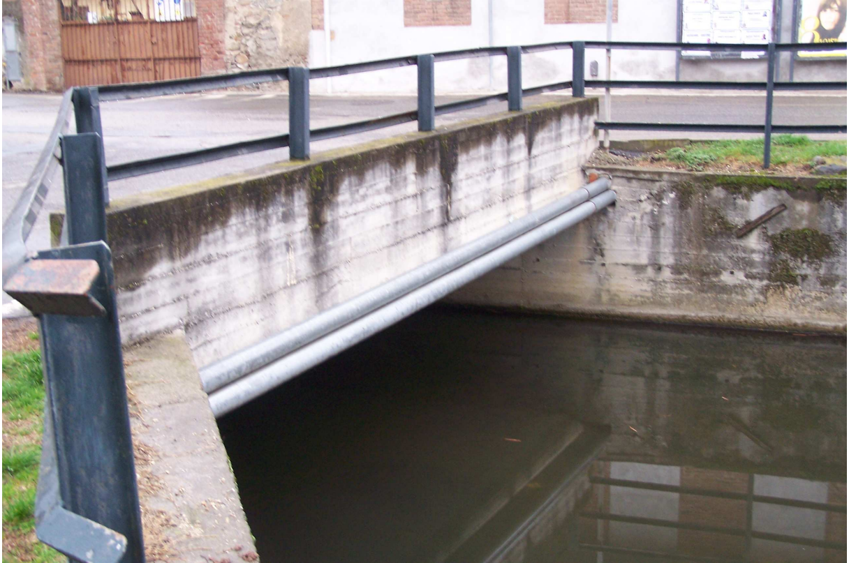
Ponte Borgiattino sul rio Sangonetto a Piosasco
